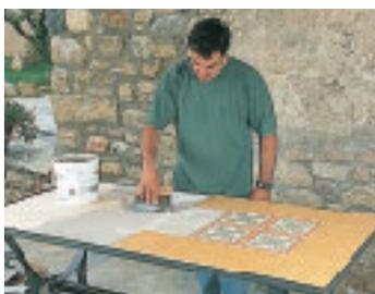
5. Après séchage de la colle, procéder au jointoyage. Étaler la barbotine à la spatule caoutchouc pour la faire pénétrer au fond des joints.
