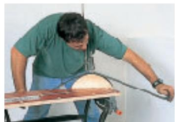
6. Vérifier chaque cintrage sur le plan grandeur nature, et rectifier au besoin.
